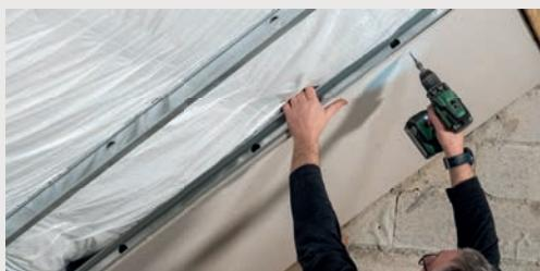
Fixer le parement de finition sur les montants.
