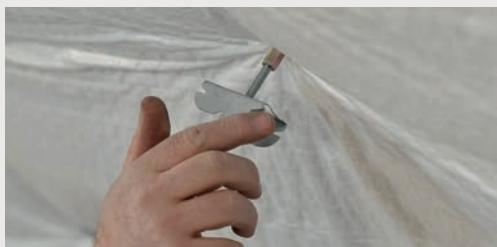
Visser les tiges filetées et mettre en place les pivots.
