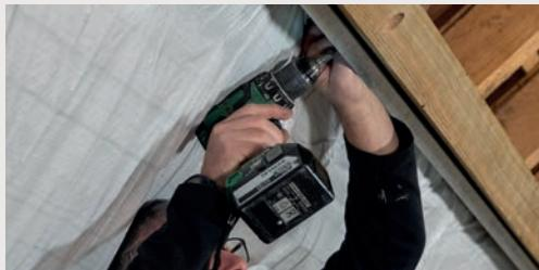
Positionner et fixer les rails supports de chaque côté des pannes à l'emplacement souhaité.
