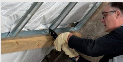
Placer les montants dans les rails conformément au **DTU 25.41** (*Travaux de bâtiment - Ouvrages en plaques de plâtre - Plaques à faces cartonnées*), les positionner à l'entraxe souhaité et les sertir.
