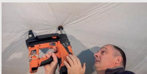
Poser un second lé entier en recouvrant de 10 à 15 cm le 1er lé en le clouant de façon identique
