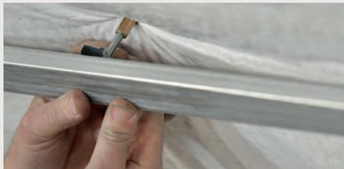
Clipper les fourrures sur les pivots et visser le parement de finition.
