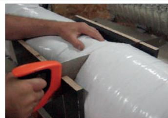
L'utilisation d'une boîte à ongles de dimension adaptée permet de découper l'isolant dans son emballage pour les découpes en largeur.
